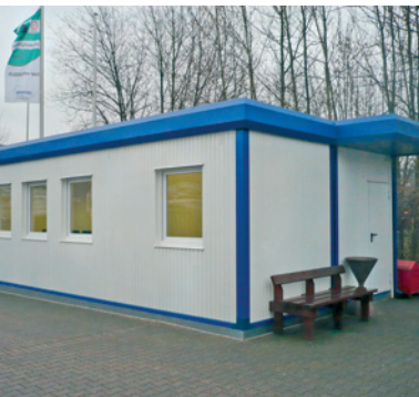
Die Prüflokalen wurden mit großem zeitlichen Vorlauf festgelegt und technisch aufgerüstet
